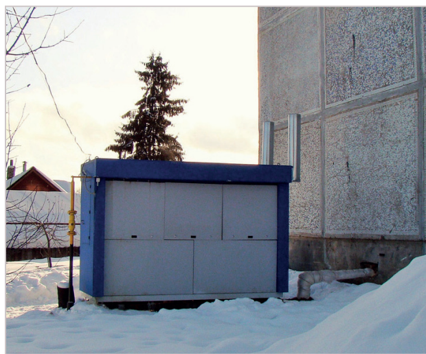
ТГУ-НОРД-240, отопление и горячее водоснабжение жилого дома. Новгородская область, г. Валдай, ул. Лесная
